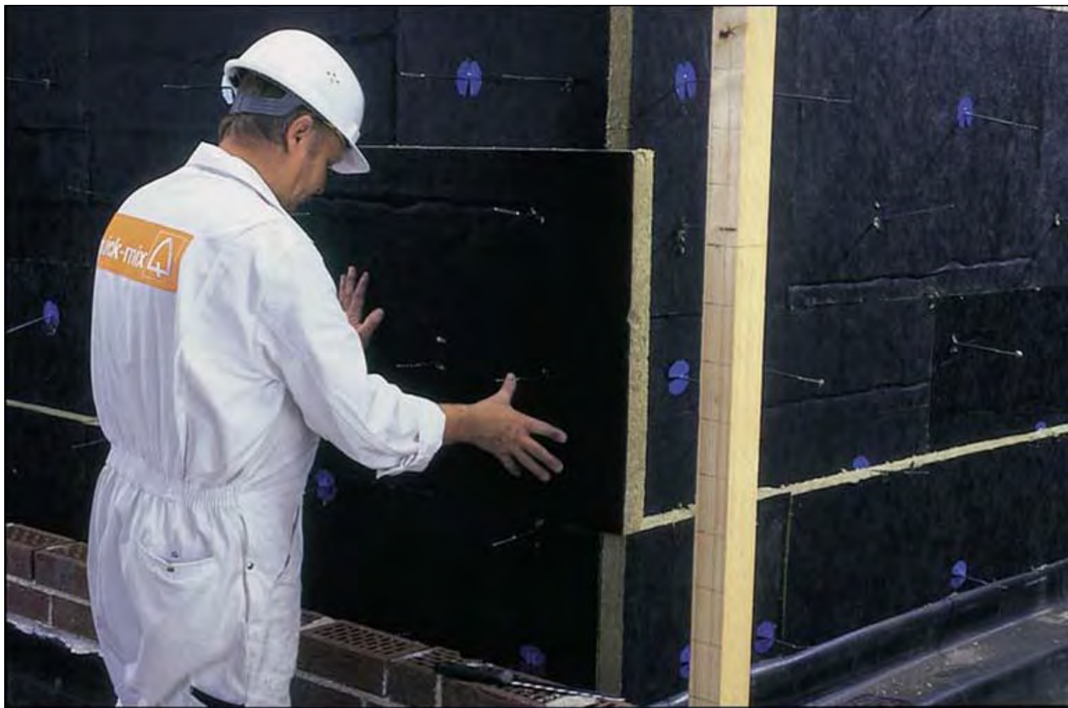
Укладка второго слоя изоляции.
